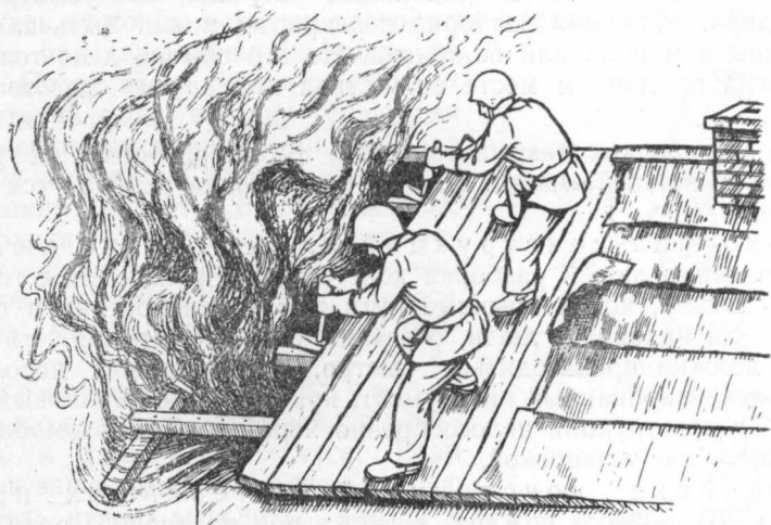
Рис. 53. Разборка кровельной опалубки.
